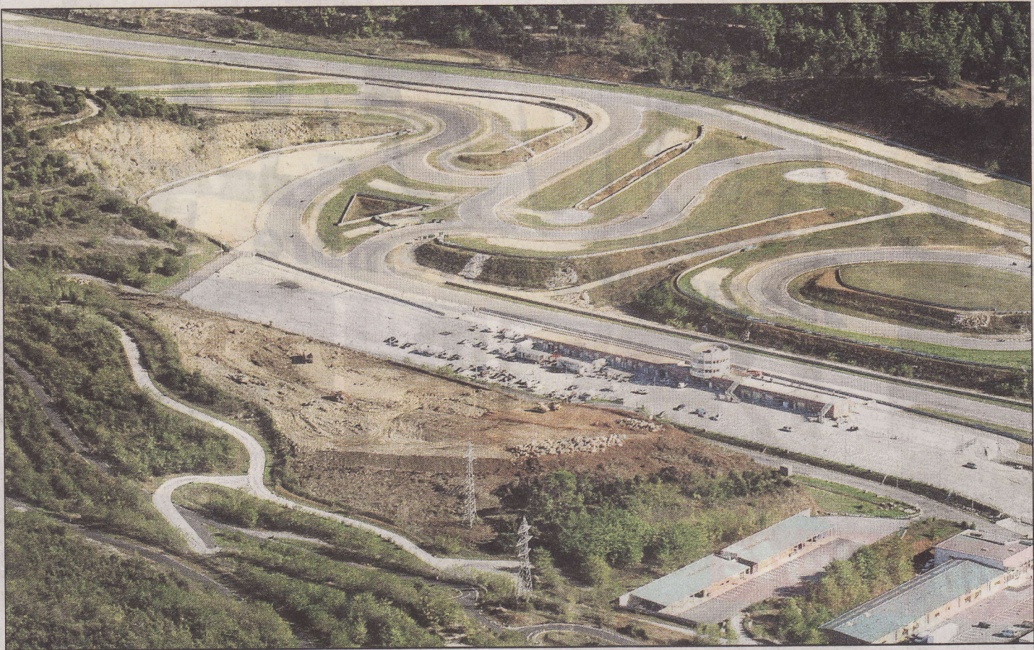
Les travaux de terrassement sont un prélude à une probable phase de développement du Pôle. Photo avec le concours de l'Aéro Club de Deaux
